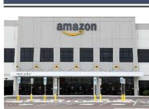
Centro de distribuição Amazon CLE2, antigo Randall Park Mall.
