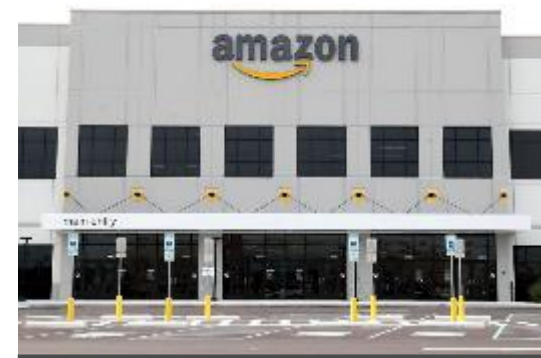
Centro de distribuição Amazon CLE2, antigo Randall Park Mall.
